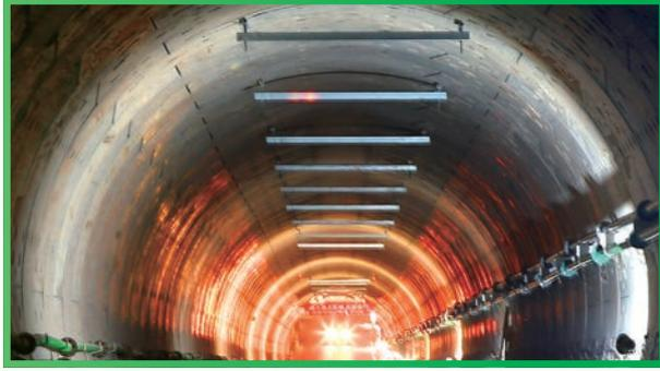
国内首座TBM长距离大坡度煤矿斜井施工
